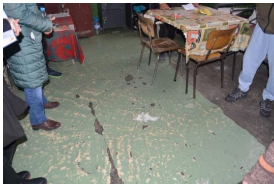
Бетонни подове в част от спалните помещения
