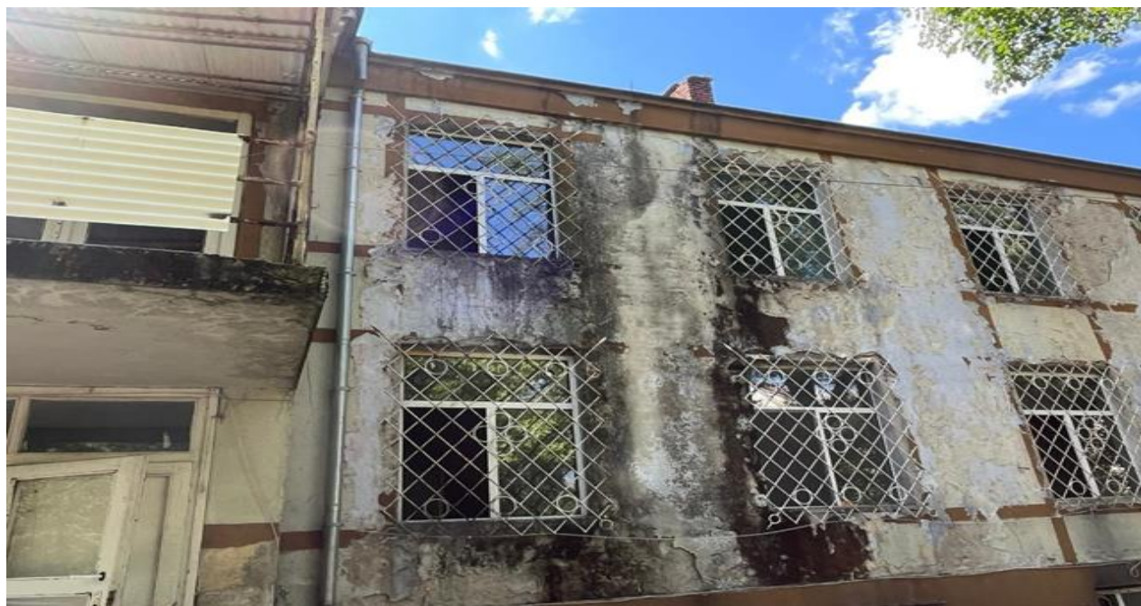
Фасадата на ДПБ - Раднево
