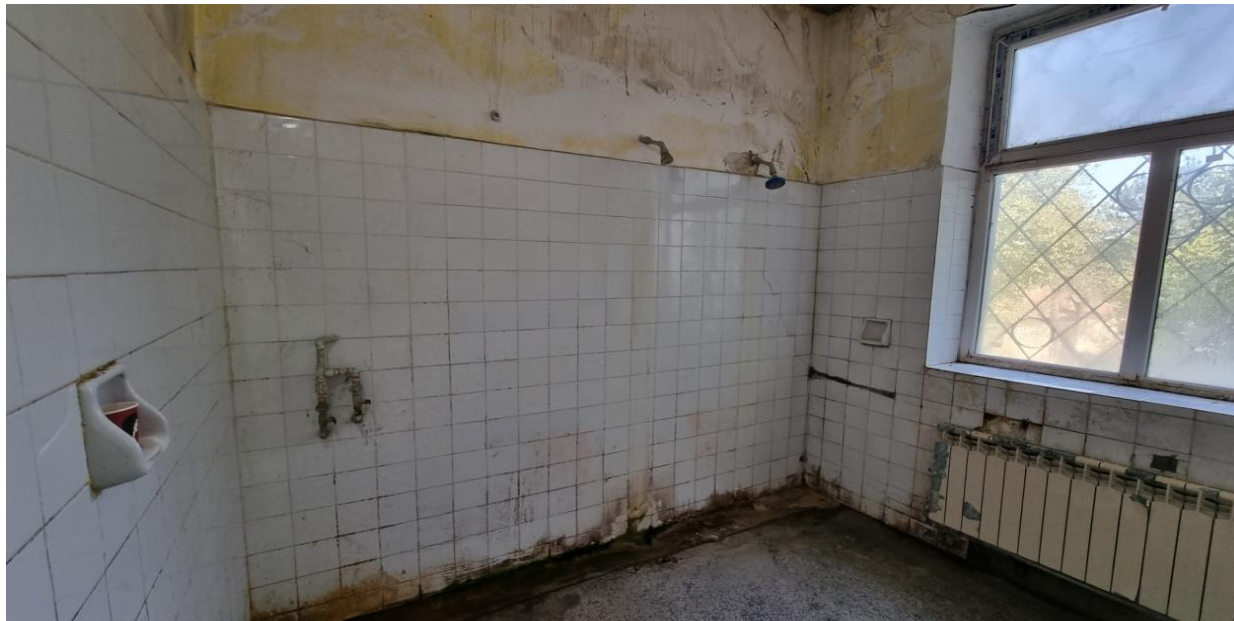
Санитарно помещение в ДБП – Бяла
