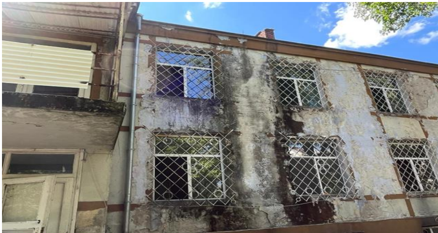
Фасадата на ДПБ - Раднево
