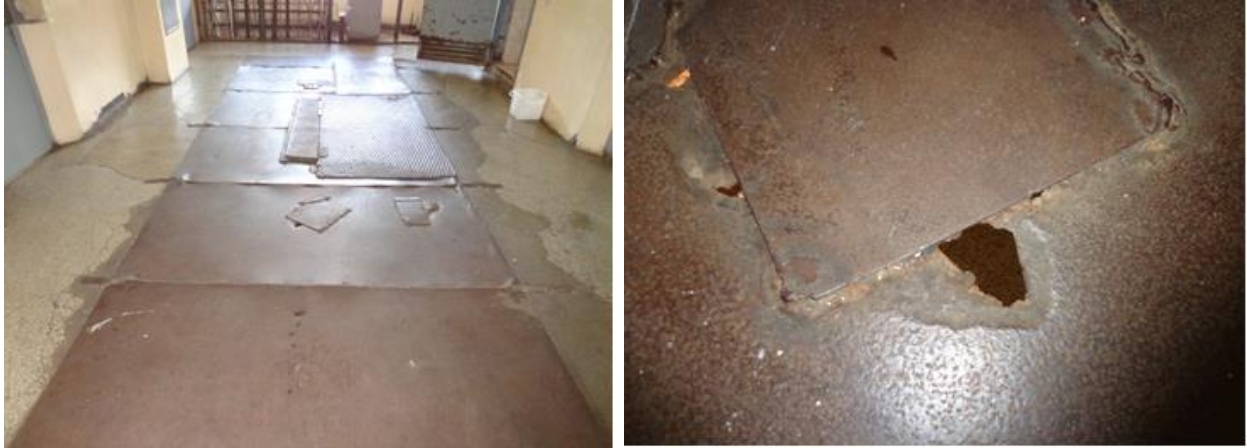
Подовите по някои от коридорите на затворническия корпус
