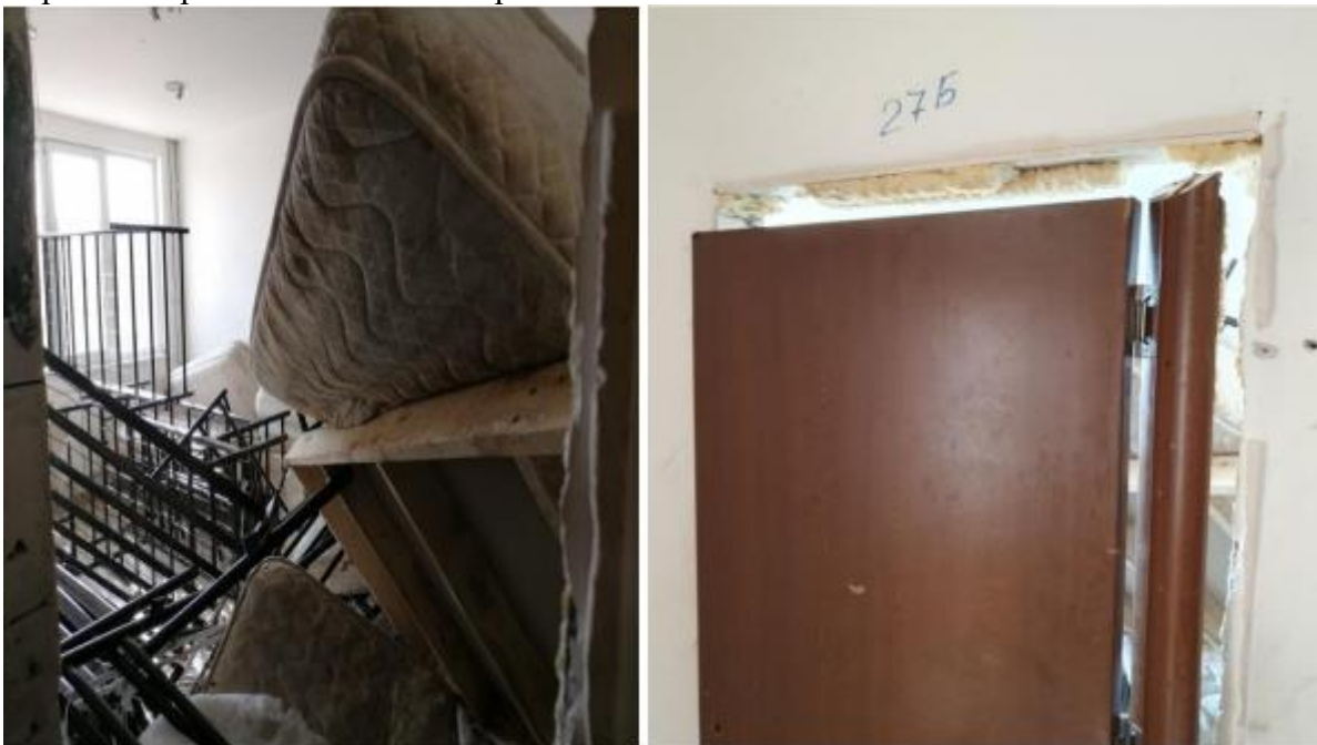
Ползваната за склад в Девето хале стая 27Б, с паднала каса, поради липса на крепежни елементи
