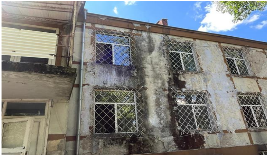
Фасадата на ДПБ - Раднево
