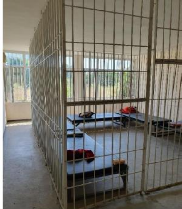
Помещение за настаняване
