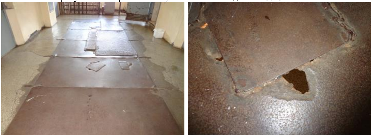
Подовете по някои от коридорите на затворническия корпус
