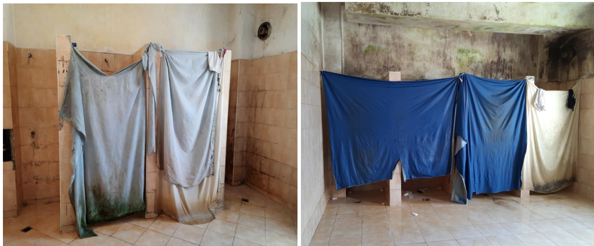
Помещения за къпане в Блок 2 на СДВНЧ-София
