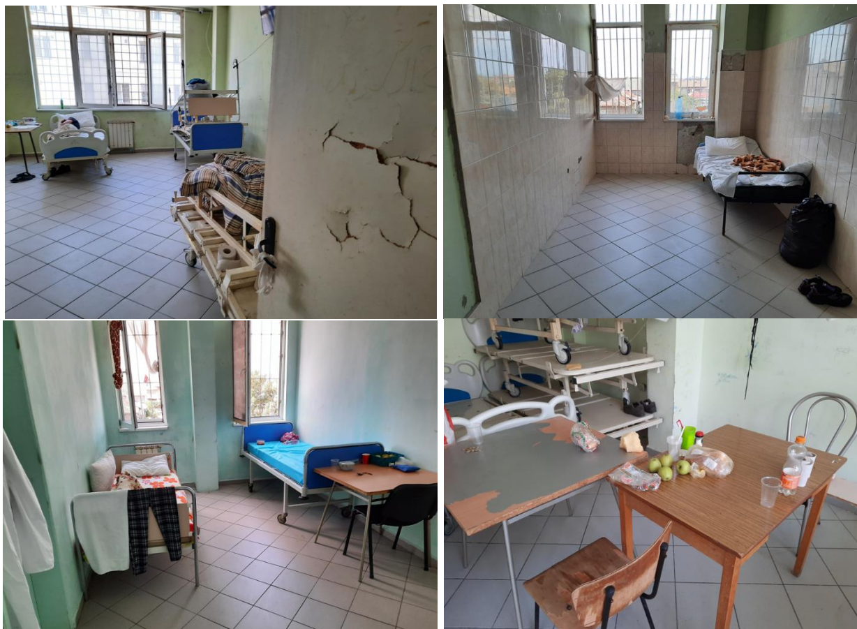
Помещения за настаняване на чужди граждани в Блок 1
