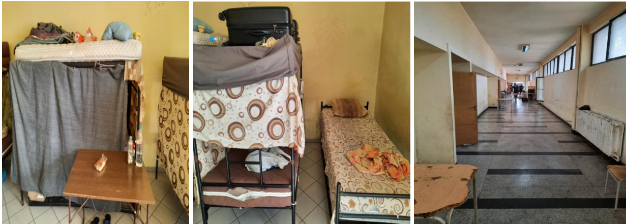
Помещения за настаняване и коридор в ПМЗ „Враждебна“
