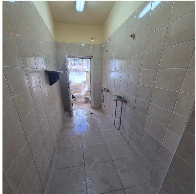
Обща баня със санитарен възел
