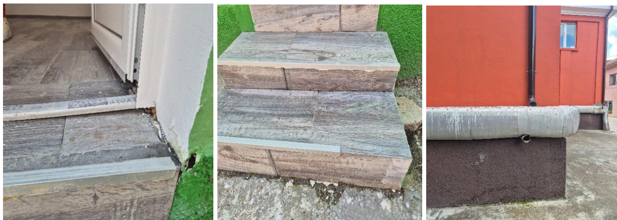
Голяма фуга под прага на външна врата, нефугирани и без лайсна стъпала и водосточна тръба до средата на стената
